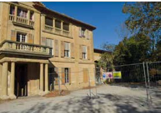
Travaux d'aménagement du Centre euro-méditerranéen de ressources sur la transhumance au domaine du Merle, novembre 2017.
