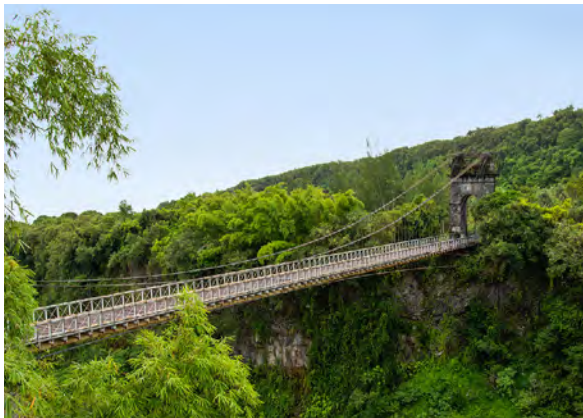
Pont suspendu de la rivière de l'Est © OCUS - Fondation du patrimoine
